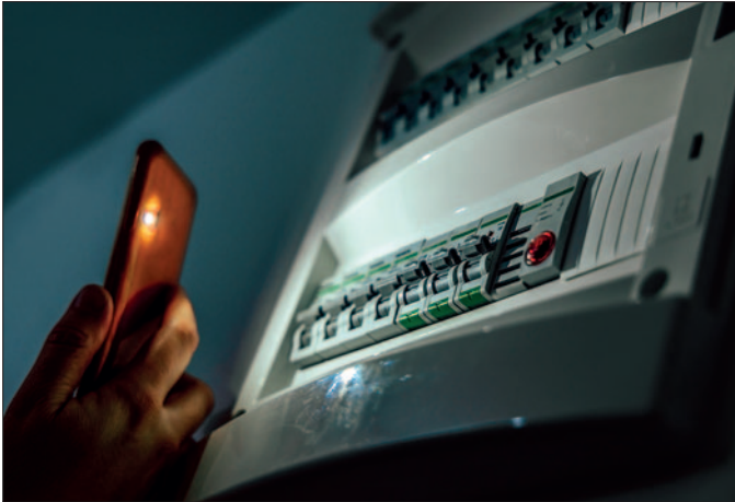
Wenn der Strom im Haushalt ausfällt, sollte zunächst der Sicherungskasten bzw. der FI-Schalter überprüft werden.
